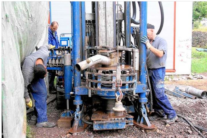
Kommt noch was? Die Erdwärmebohrungen hatten gestern einen Auftakt nach Maß - nur eine Grundwasserschicht, kein Gips und kein Muschelkalk im Untergrund. Fotos: Werner Müller
